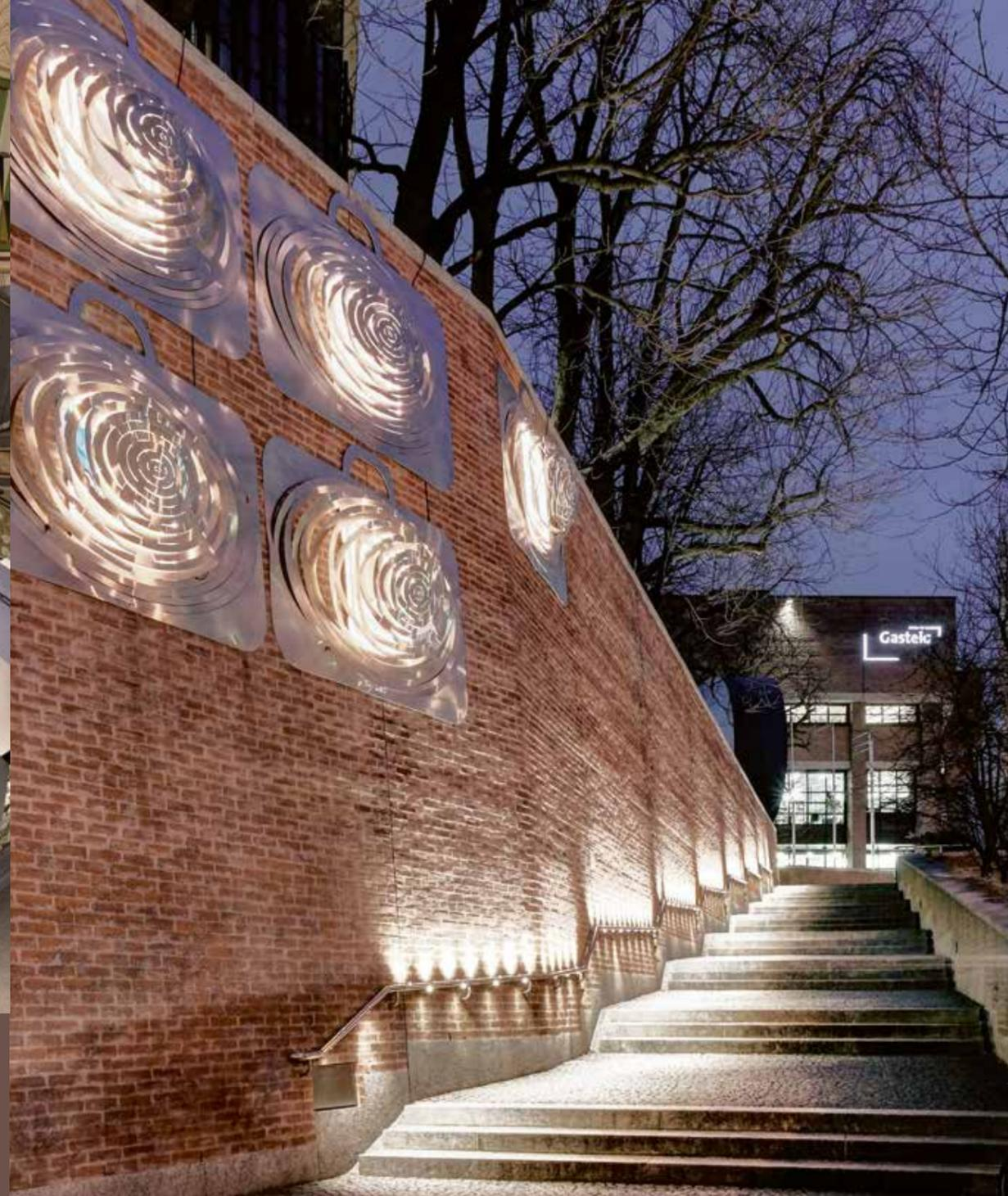
Dank der flexiblen Einzelanordnung ist der PUCK sowohl bei gerader als auch gebogener Linienführung einsetzbar, was gerade bei den vorliegenden engen Radien im Landgericht Halle erforderlich war. Perfekte Integration: durch einen zweiten dezenten Handlauf aus Aluminium, der dem historischen vorgesetzt wurde, wird die Lichtquelle nicht wahrgenommen.
