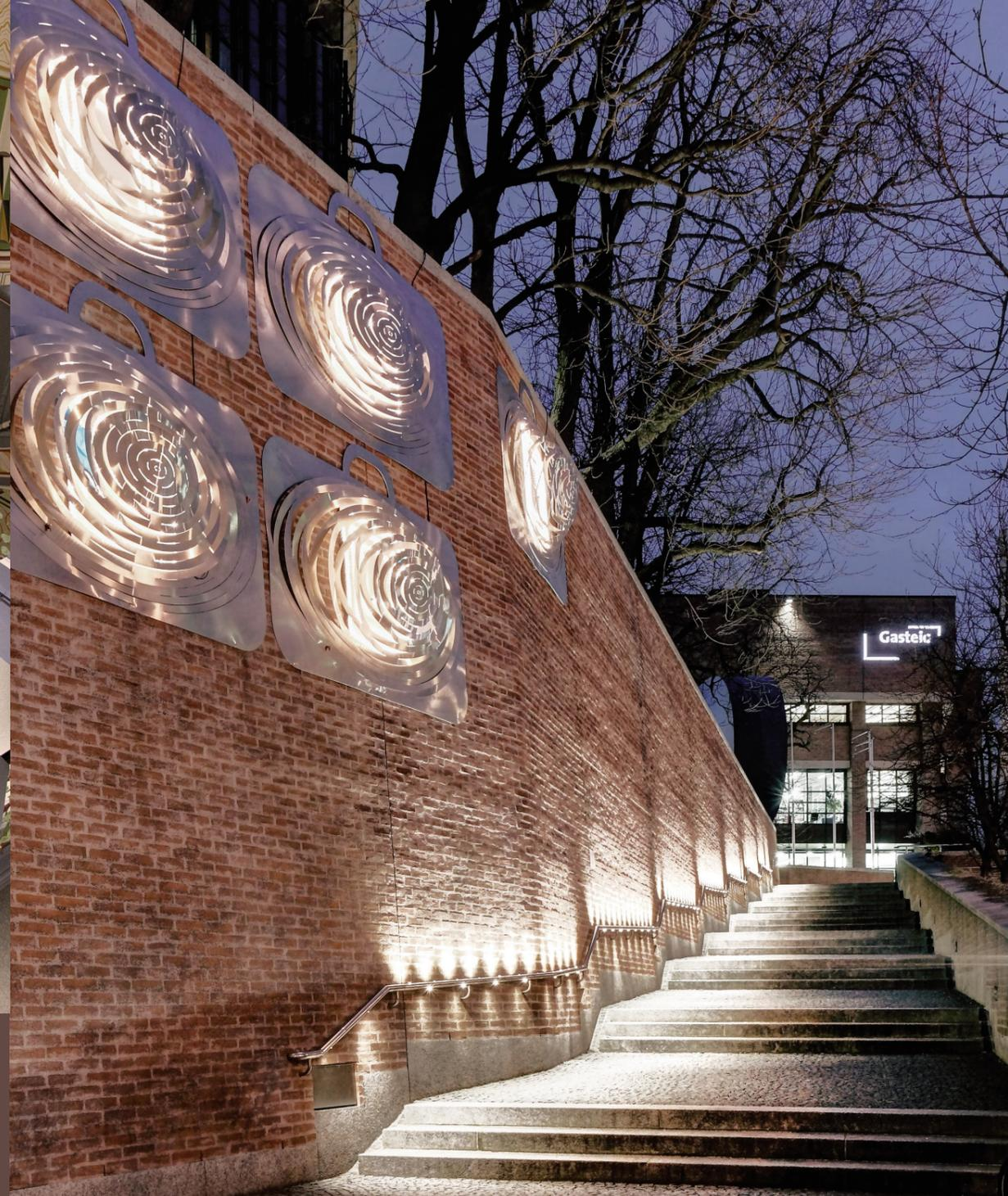
Dank der flexiblen Einzelanordnung ist der PUCK sowohl bei gerader als auch gebogener Linienführung einsetzbar, was gerade bei den vorliegenden engen Radien im Landgericht Halle erforderlich war. Perfekte Integration: durch einen zweiten dezenteren Handlauf aus Aluminium, der dem historischen vorgesetzt wurde, wird die Lichtquelle nicht wahrgenommen.
